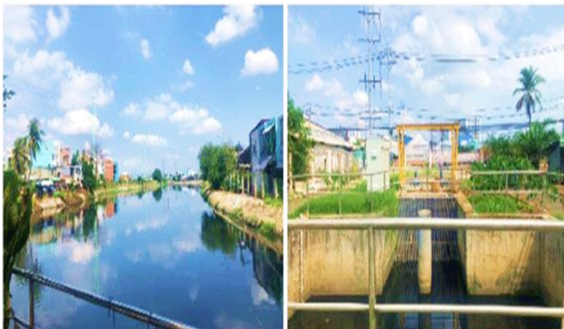
Hồ điều tiết giảm ngập Mễ Cốc, Quận 8.
